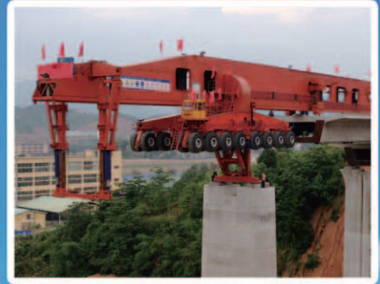
學校具有獨立知識產權的SLJ900架橋機正在作業
